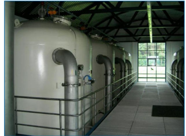
Filterhalle unserer Trinkwasseraufbereitungsanlage Bad Berka (© WZV Weimar)
