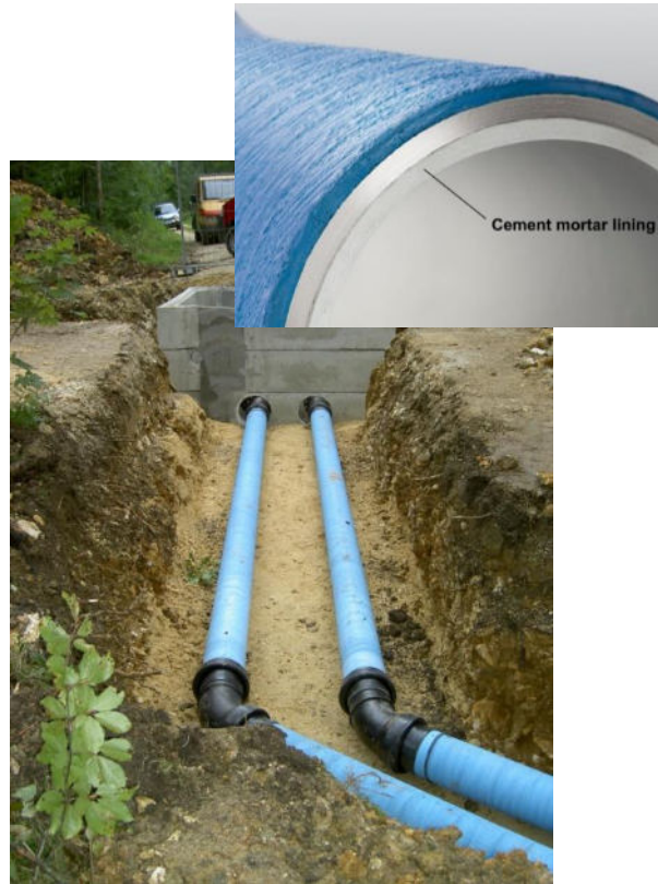
Zementausgekleidetes Gussrohr © EADIPS
