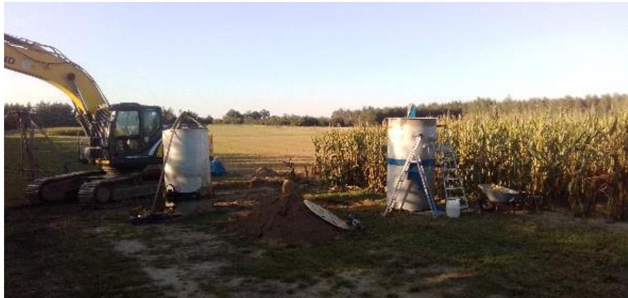
„Ein Lysimeter (von griech. lysis = Lösung, Auflösung und metron = Maß) ist ein Gerät zur Ermittlung von Bodenwasserhaushaltsgrößen und zur Beprobung von Bodensickerwasser, um dessen Quantität und Qualität zu bestimmen.“
