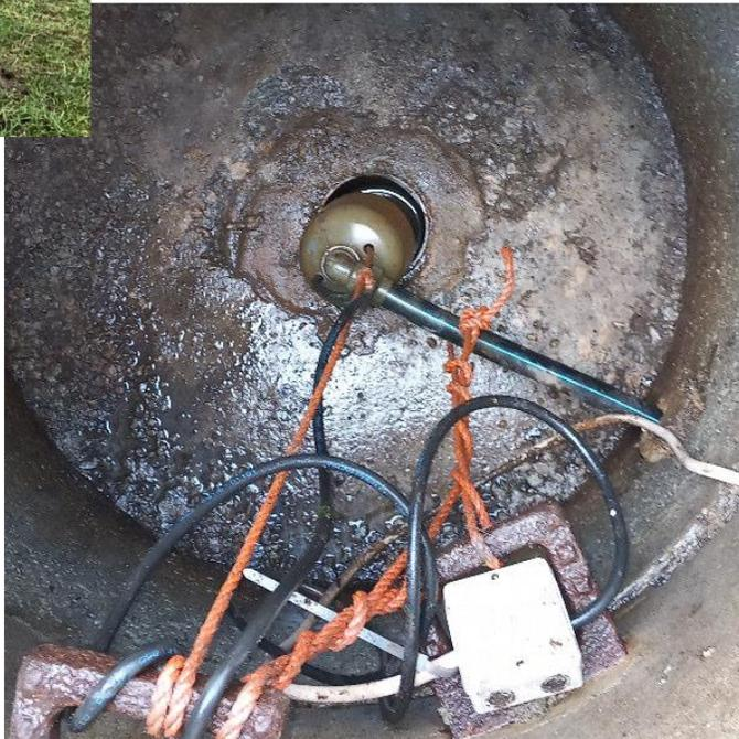
Abb.6 : Bohrbrunnen – fehlende Mantelrohrabdichtung-
