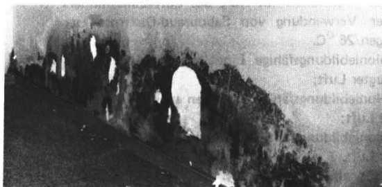
Abb. 3: Verschimmelung einer Schreibzimmerwand. Ein undichter Wasserrohranschluß in der Zimmerwand, durch einen Bücherschrank verdeckt, führte zu einem versteckten, breitflächigen, massiven Schimmelpilz-Wachstum (Dematiaceae). Der in diesem Raum Beschäftigte erkrankte an akuten Asthma-Anfällen und Bronchitis.
