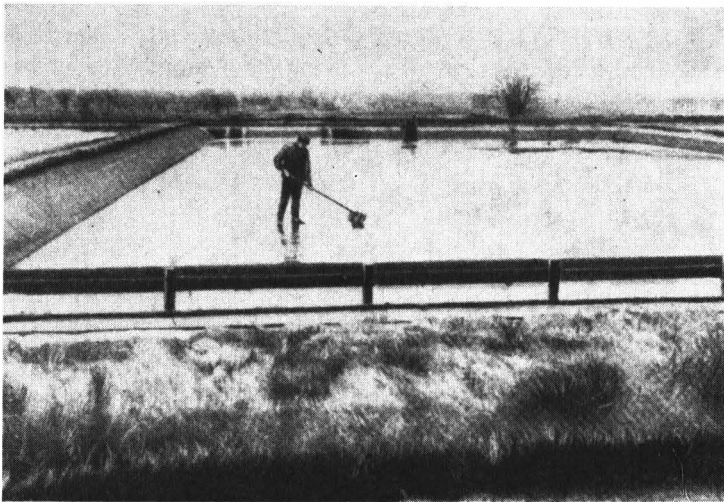
Abb. 3. Absetzbecken beim Räumen des Schlammes 6) (im Vordergrund die Tauchbohlen vor der Überfallkante am Ablauf).
