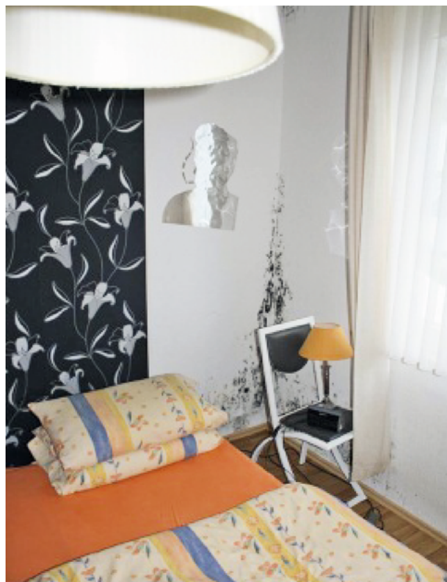
Abb. 1: Einzimmerwohnung eines mehrfach an den Nasennebenhöhlen operierten Patienten; starke Verpilzung der Wände, hauptsächlich bedingt durch ausbleibende Lüftung
