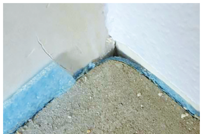
Abb. 12: Ausbildung einer Innenecke mit dahinter gestellten Randdämmstreifen, Hohlraumbildung (Quelle/Foto: Dr. C. Kroczeck, 2019)
