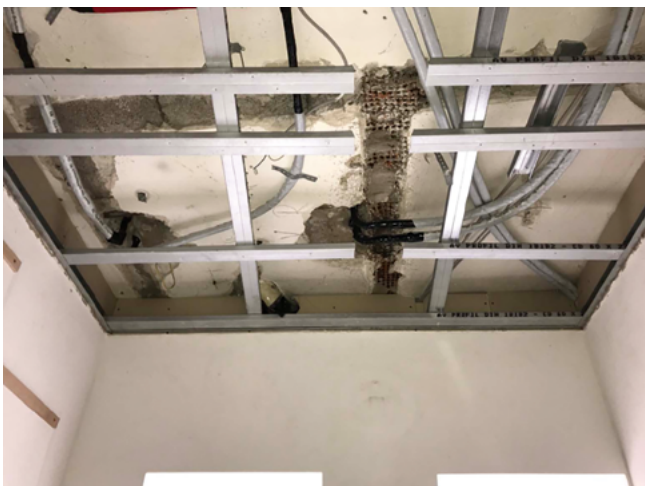
Abb. 21: Abgehängte Decke, zahlreiche Durchdringungen des Deckenaufbaus für diverse Installationen (Quelle/Foto: J. Thumulla, 2020)
