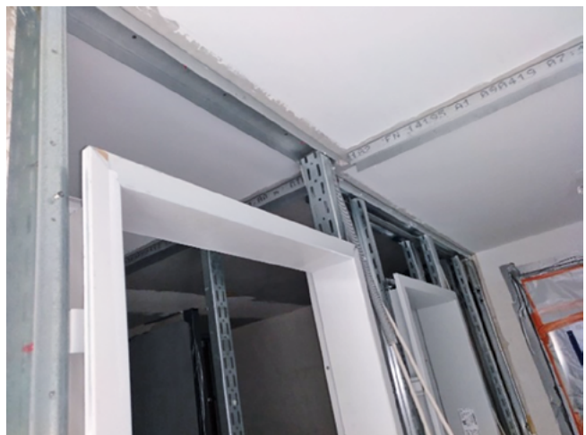
Abb. 22: Türrahmen in Leichtbau-Ständerwand: keine definierte Abdichtung zwischen Hohlraumluft und Raumluft möglich (Quelle/Foto: Dr. C. Kroczeck, 2020)
