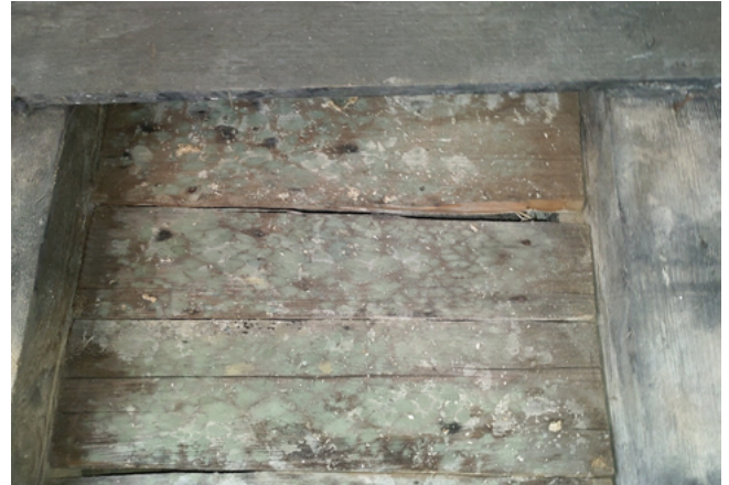
Abb. 24: Deckenaufbau über dem Salon. Die Fehlbodenbretter wurden jeweils umgedreht und ansonsten an ihrer Position belassen (Quelle/Foto: J. Thumulla, 2020).
