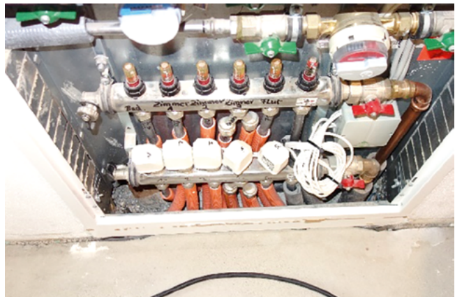
Abb. 16: Praxisbeispiel üblicher Heizungsverteilerkasten (Quelle/Foto: Dr. C. KroczeK, 2019)
