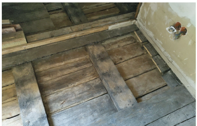
Abb. 23: Bis zur Fehlbodenebene rückgebauter und gereinigter Fußbodenaufbau über dem „Salon“ (Quelle/Foto: J. Thumulla, 2020)
