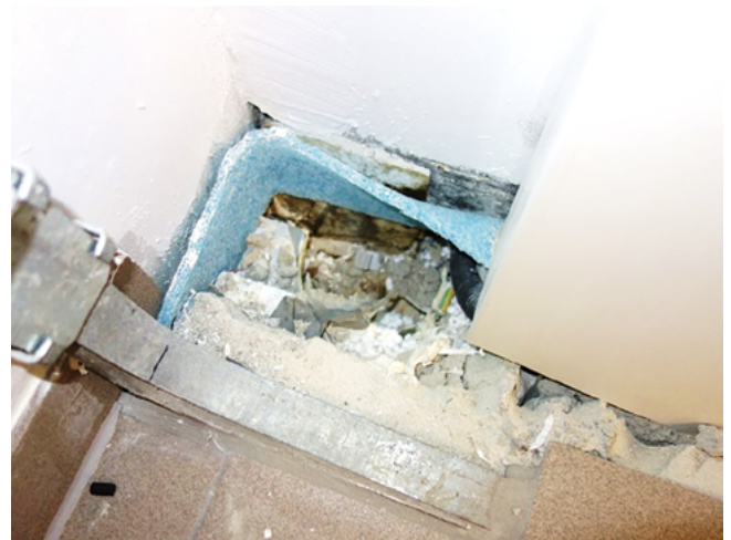
Abb. 11: Loser Estrich-Randdämmstreifen an einer Innenecke bei Rohrdurchführungen (Quelle/Foto: Dr. C. Kroczeck, 2019)
