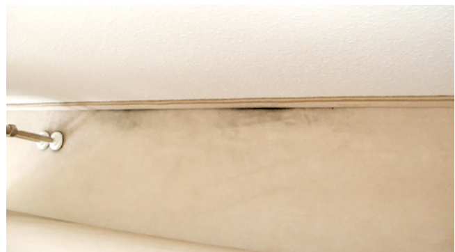
Abb. 9: Austritt von dunklen Partikeln (auf weißem Teppichboden) an Undichtigkeiten an den Estrichrandfugen (Quelle/Foto: J. Thumulla, 2015)
