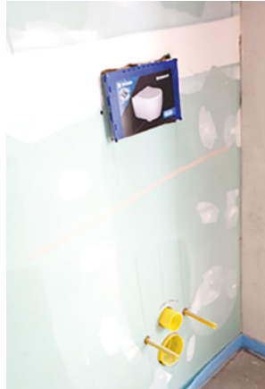
Abb. 20: Toiletten- und Spülkastenanschlüsse in Trockenbauvorwand (Quelle/Foto: Dr. C. Kroczeck, 2020)
