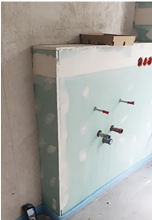
Abb. 17: Praxisbeispiel: Trockenbauvorwand mit Durchdringungen durch Anschlussrohre und Steckdosen, keine Abklebungen mit Aluminiumband der Ränder (Quelle/Foto: Dr. C. Kroczeck, 2019)
