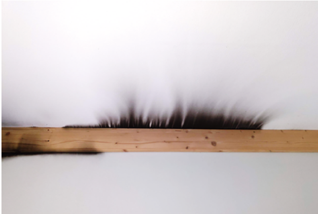
Abb. 19: Austritt von schwarzen Rauchpartikeln an Gipskartondecke nach einem Brandschaden (Quelle/Foto: J. Thumulla, 2013)
