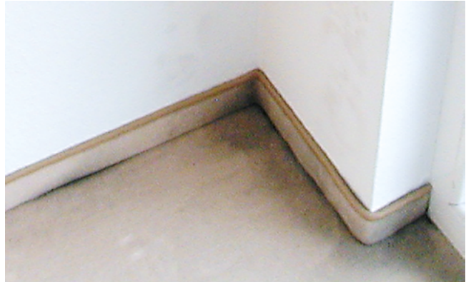
Abb. 14: Austritt von dunklen Partikeln an Estrichrandfugen an Innen- und Außeneckbereichen, lückenhafte undichte Randdämmstreifen sind zu vermuten (Quelle/Foto: J. Thumulla, 2013).
