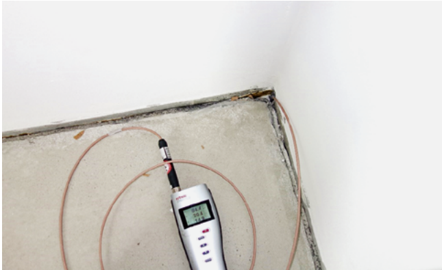
Abb. 13: Ausbildung einer Innenecke mit dahinter gestellten Randdämmstreifen, keine Parallelbildung am Wandbereich, Messinstrument ist bis auf Bodenplatte im Hohlraum versenkbar (Quelle/Foto: Dr. C. KroczeK, 2019).
