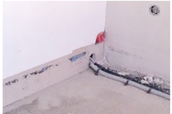
Abb. 18: Leitungsdurchdringung Gipskartonwand unterhalb Estrich-Randdämmstreifen unten rechts, keine weiteren Abdichtungen (Quelle/Foto: Dr. C. Kroczeck, 2019)
