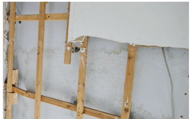
Abb. 25: Deckenkonstruktion nach Öffnung mit deutlich sichtbarem Schimmelbefall (Quelle/Foto: J. Thumulla, 2020)
