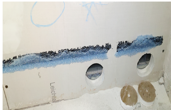
Abb. 8: Nach Rückbau sichtbare Fehlstellen in der Verklebung des Randdämmstreifens (Quelle/Foto: Dr. C. Kroczeck, 2020)
