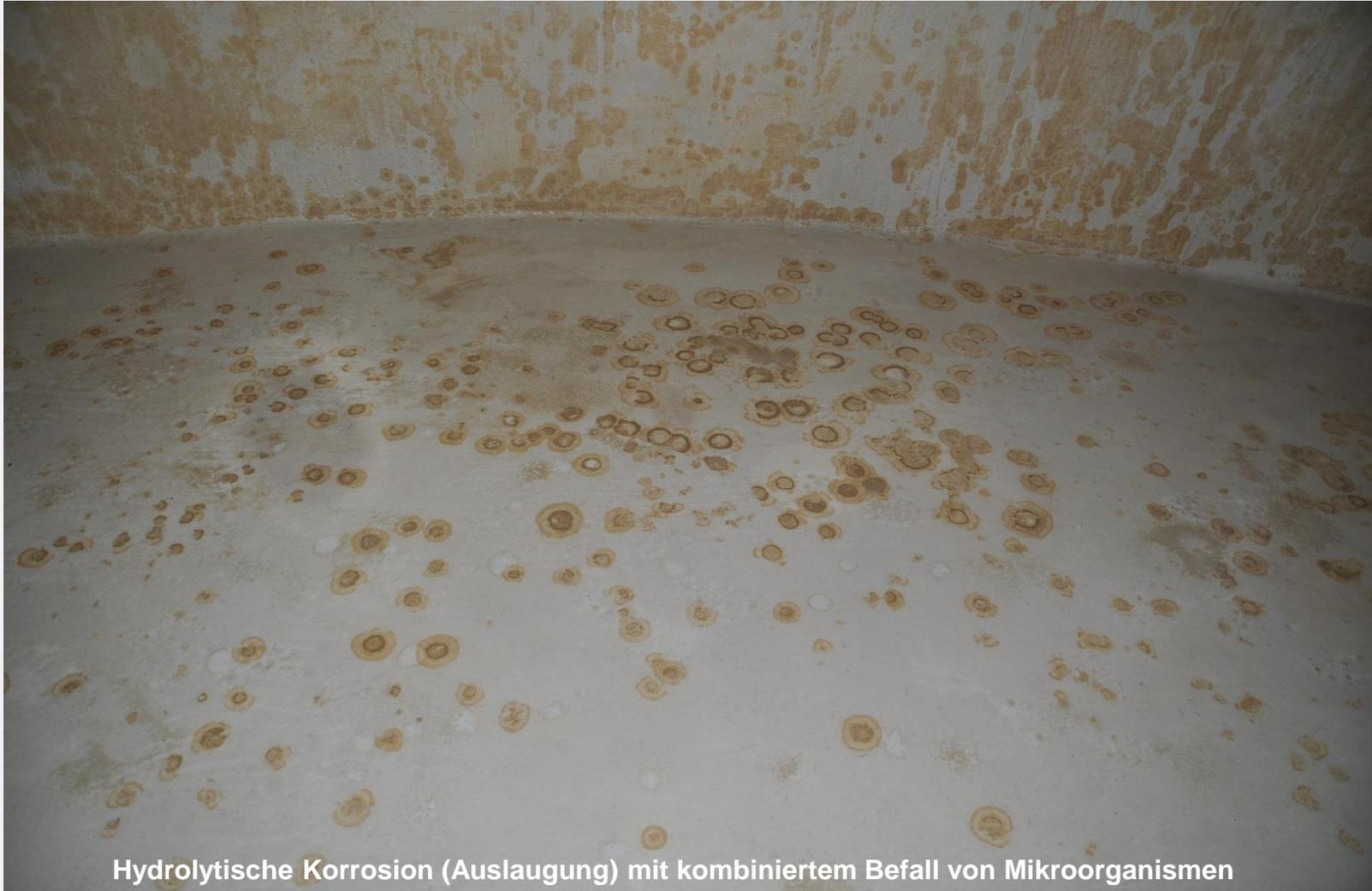
Hydrolytische Korrosion (Auslaugung) mit kombiniertem Befall von Mikroorganismen
