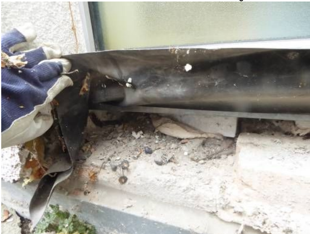
Foto 10: Fensterbank von außen geöffnet, Luftverbindung über Hohlraum zum Innenraum
