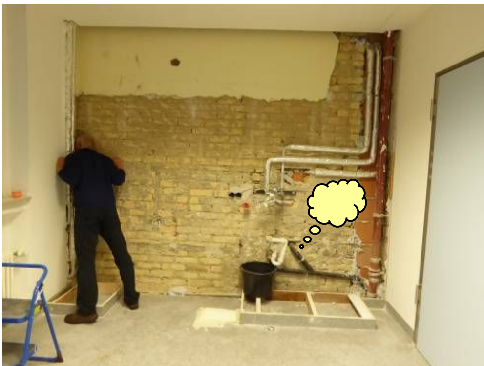
Foto 11: Geruchliche Prüfung der freigelegten, östlichen Innenwand
