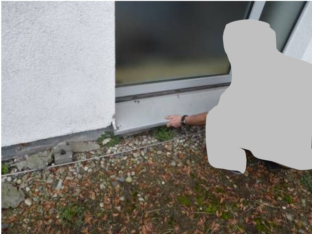
Foto 9: Fensterbank vor dem Raum wird vom Gründach aus geöffnet
