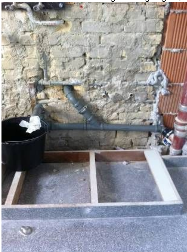
Foto 12: ausgetauschte Abwasserrohre
