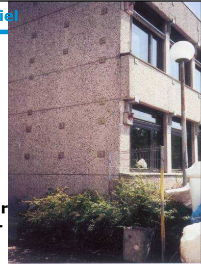
Korrodierte DURISOL-Fassade an einem Schulgebäude, vorläufig gesichert; Fugendichtstoff mit PCB-Anteilen
