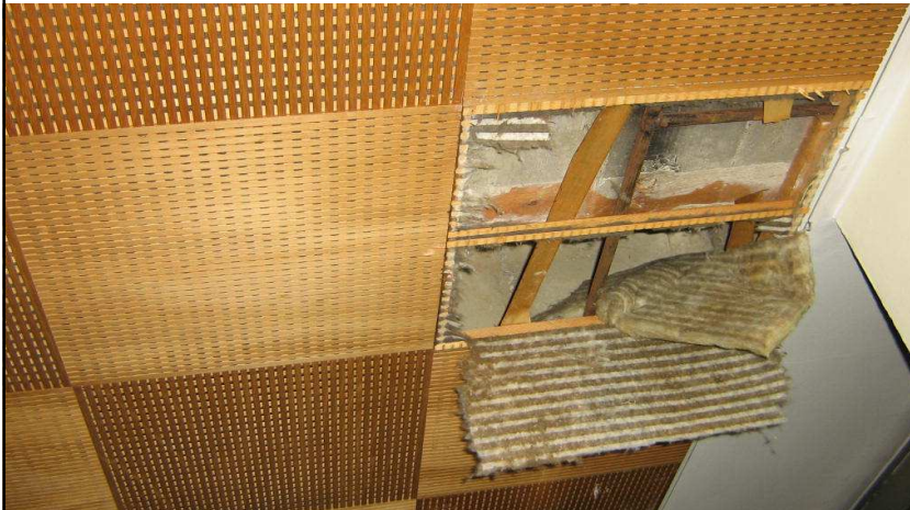
KMF – Akustikdecke Staubablagerungen
